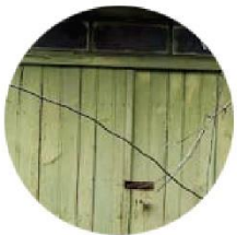
Ξύλινη σανιδωτή θύρα
